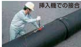
挿入機での接合
